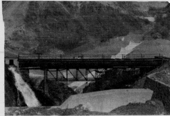
仁田元沢の土砂止めの堰
